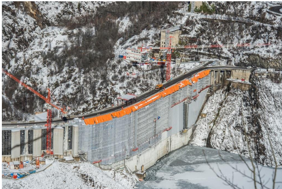
Figure 1 : Barrage du Chambon lors des travaux de pose de la géo membrane en PVC après sciage du corps du barrage ( http://www.carpitech.com ).
